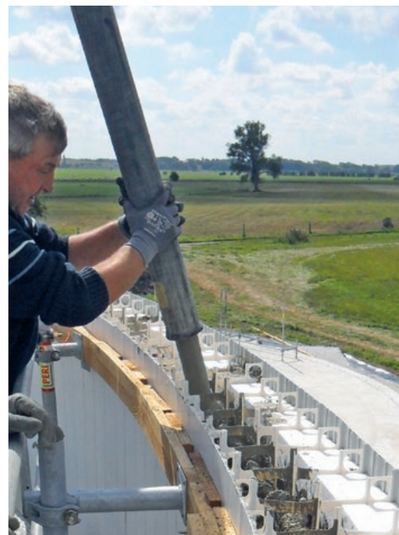
Eingießen des Betons
